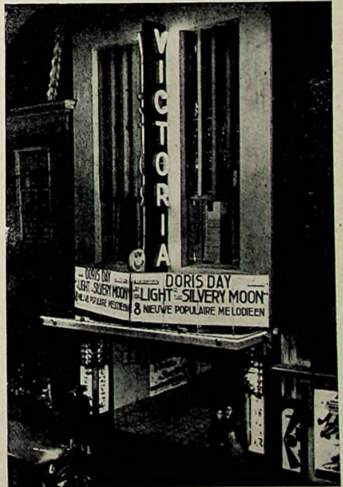
Een paneel-lichtreclame op de luifel van een bioscoop. Elk paneel is 105 cm hoog en 300 cm breed. Het aantal letters dat bij deze installatie hoort is ruim 600. De verlichting geschiedt doormiddel van 6 Fluor-buizen van 40 watt in elk paneel.
